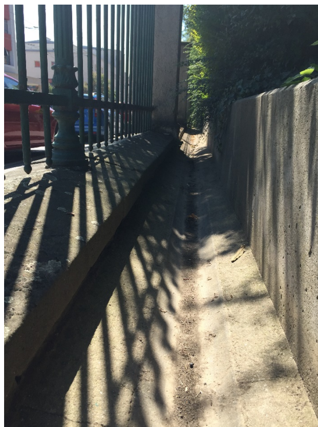
Odvodňovací žlab s návazností na opěrnou a plotovou zídku
